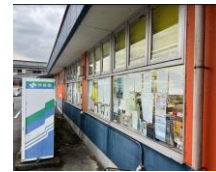
ガラス窓 に遮熱 フィルム
