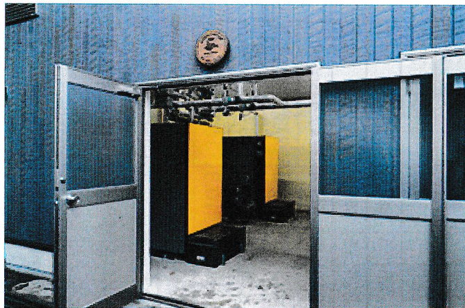
新たに導入したバイオマスボイラー
