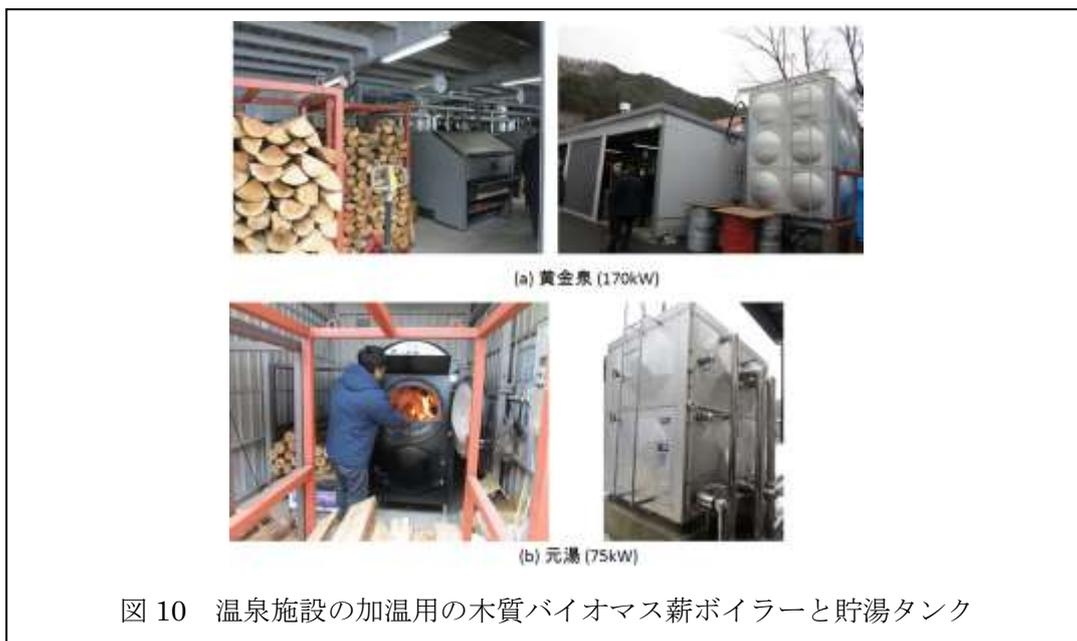
図 10 温泉施設の加温用の木質バイオマス薪ボイラーと貯湯タンク
